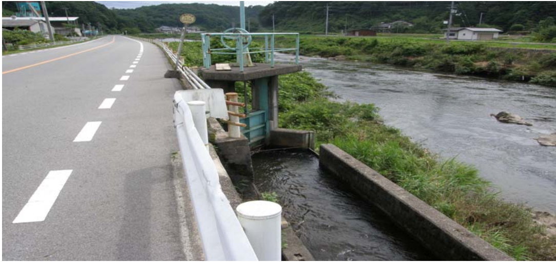
写真 4. 浄化槽の補給水採水場所
