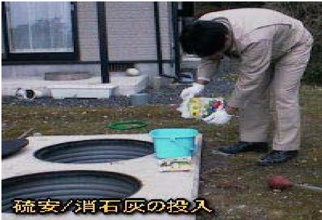
写真 8. 浄化槽内のサカマキガイを硫酸で除去する様子
