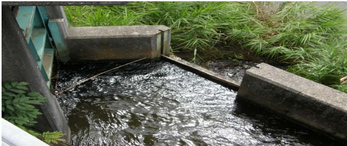
写真 5. 浄化槽内の補給水採水場所（その 2）
